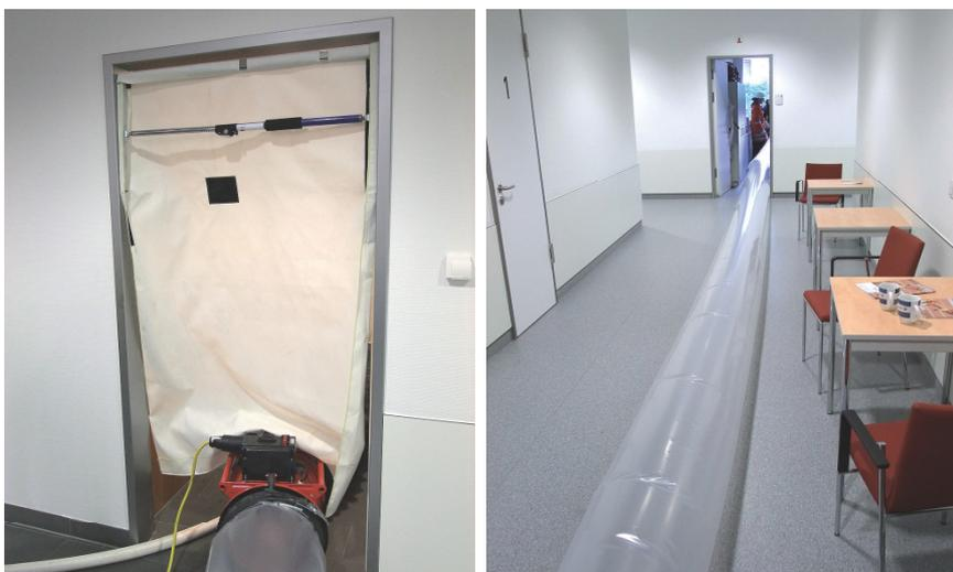
links: Brand im Klinikum im Bad Wildbad am 5. August 2010: Der Mobile Rauchverschluss verschließt die Zugangstür zum Brandraum. rechts: Die Rauchgase werden aus dem Gebäude hinausgeleitet.
