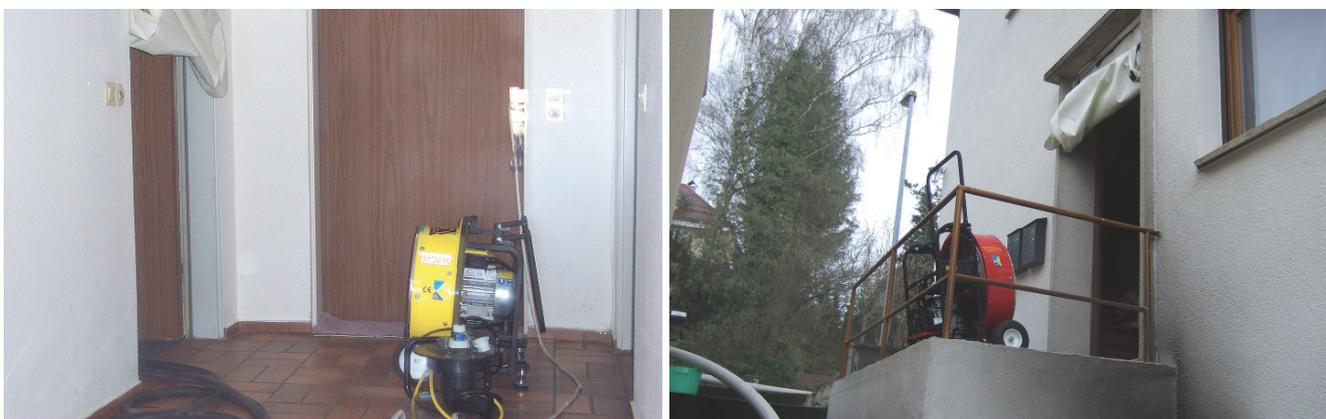
links: Der Mobile Rauchverschluss als Hilfsmittel für die mechanische Belüftung bei einem Wohnungsbrand und ... rechts: ... bei einem Gebäudebrand.
