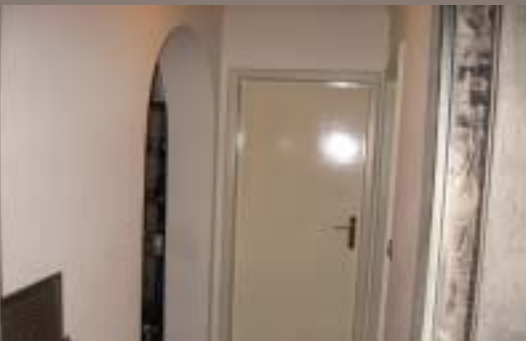
Bild 4 | Durch den Einsatz eines mobilen Rauchverschlusses ist eine deutliche Schwarz-Weiß-Trennung zu erkennen
